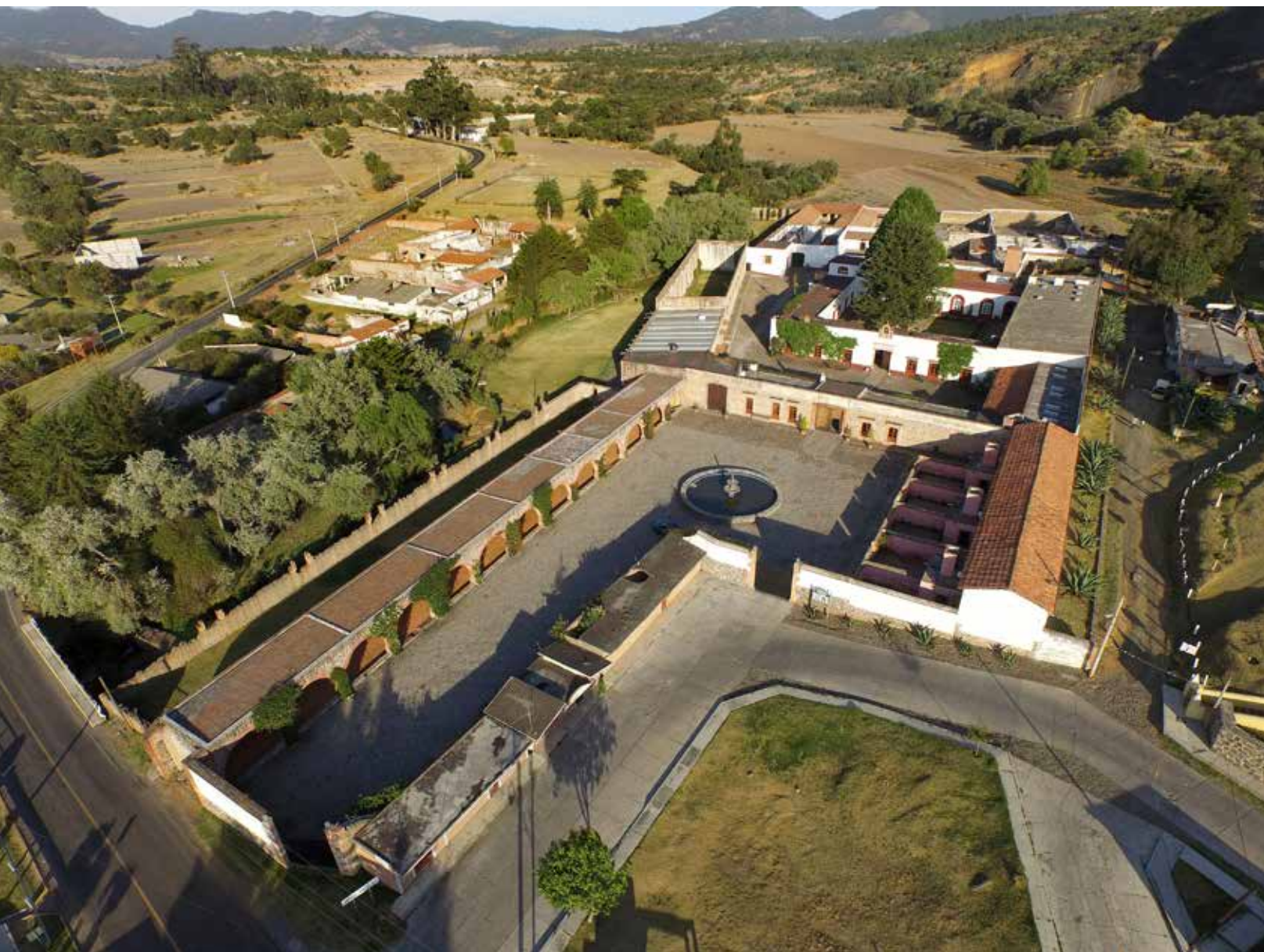
VISTA AÉREA DE SANTA MARÍA XALOZTOC. P. 143, ARRIBA: PATIO DE DICHA HACIENDA. ABAJO: VISTA EXTERIOR DE LA MISMA.
