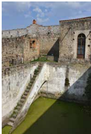
ARRIBA: OBRAS HIDRÁULICAS EN GUADALUPE. ABAJO: OBRAS HIDRÁULICAS EN SANTA BÁRBARA. P. 25: EN SAN ANTONIO TEPETZALA SE PUEDE ENCONTRAR UN ARADO METÁLICO DE RUEDAS, EL CUAL CON EL TIEMPO SUSTITUYÓ AL ARADO ROMANO Y PERMITIÓ HACER SURCOS MÁS PROFUNDOS Y PRECISOS.
