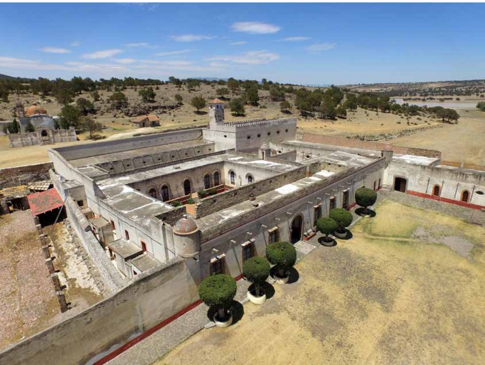
VISTA AÉREA DE SAN PEDRO TENEXAC. P. 117, ARRIBA: CAPILLA DE LA MISMA HACIENDA. ABAJO: HABITACIÓN DE LA MISMA.
