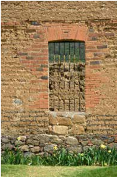
ARRIBA: FUENTE EN EL PATIO DE TRABAJO DE SANTA MARIA XALOZTOC. ABAJO: UNO DE LOS MUROS QUE DIVIDÍAN LOS PATIOS EN SAN ANTONIO TEPETZALA.
